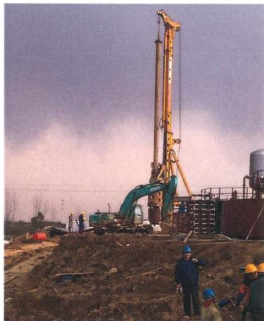
南面，现场地质条件恶劣，很大程度上增加了施工难度，特别是第一个分项工程——桩基。同时，作为高淳区生活垃圾焚烧发电厂道路改造工程，关系到发电厂项目能否正常运行，为确保在保证安全与质量的前提下加快施工进度，经过慎重考虑，决定使用旋挖钻桩机进行桩基施工，同时综合现场各项施工条件，进行多次沟通论证之后，3月1日下午三点半，桩机缓缓下行四十分钟，并经过多次调整后，终于稳稳地停在3#平台上，这也预示着桩基施工即将正式开始。
