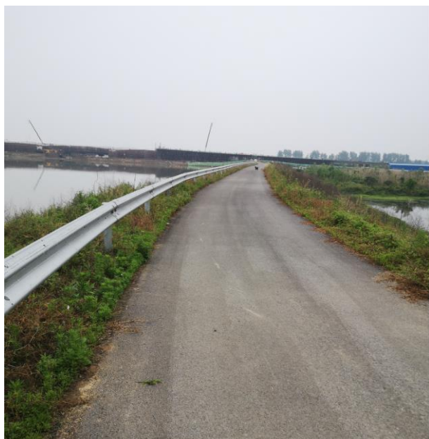
施工通道路面硬化
