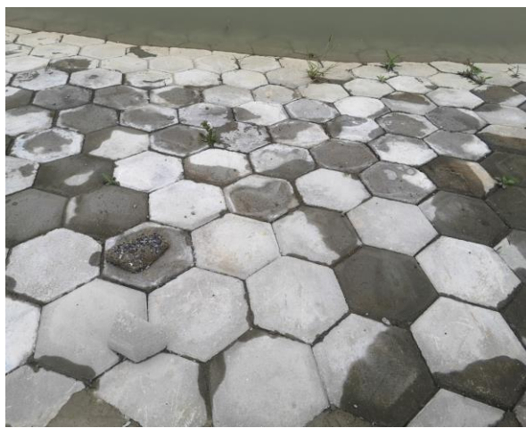
预制块护坡工程
