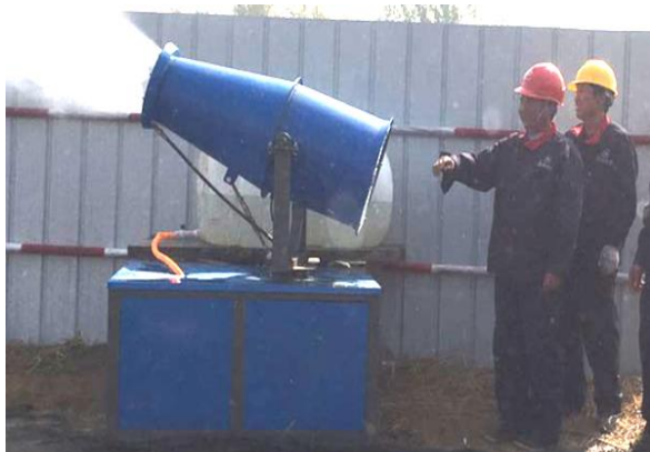
施工区洒水抑尘
