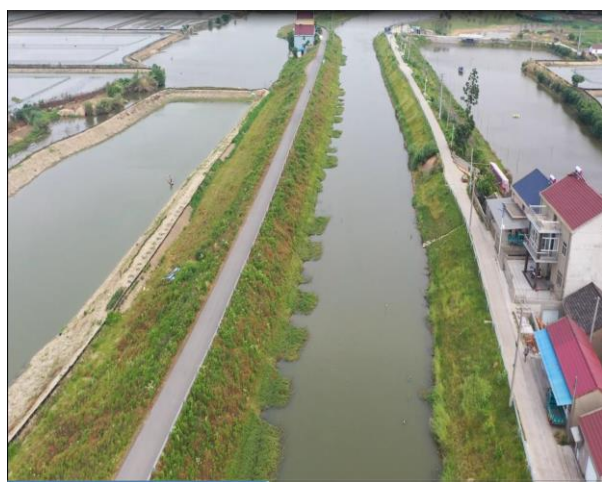
石固河中段堤顶道路区两侧草皮护坡
