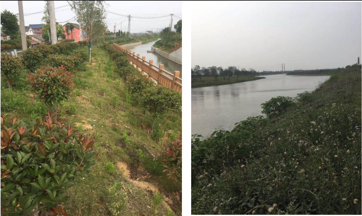
石固河中段堤防工程区草皮护坡
