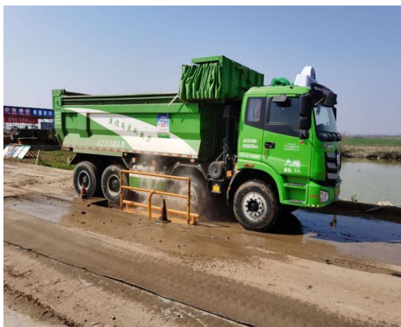
堤顶道路入口处洗车平台
